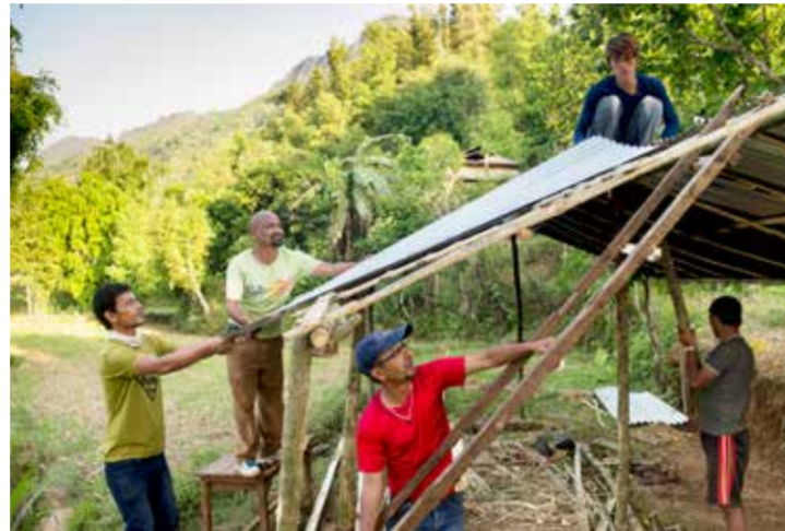
Byggarbetarna från Katmandu river och bygger nytt i Jyamrung.
